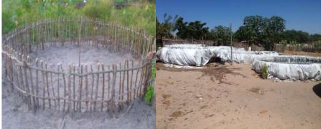
Figura 1: Estrutura do tanque em construção e (B) em funcionamento.
