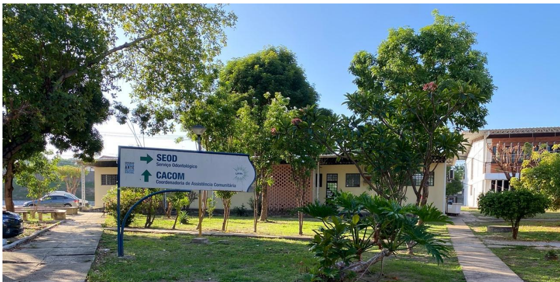
Figura 2 - Prédio da Coordenadoria de Assistência Comunitária (CACOM).
