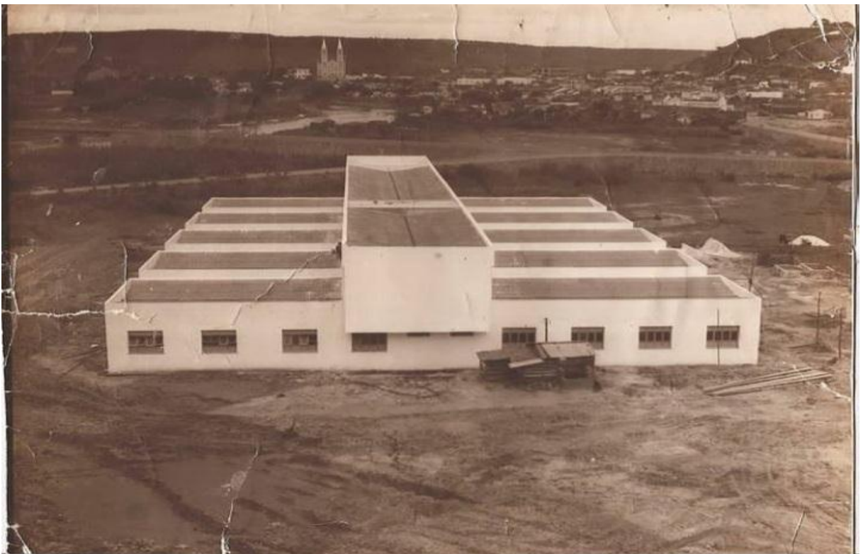
FIGURA 6: Prédio do Colégio Marcos Parente visto pelos fundos (década de 1980).
