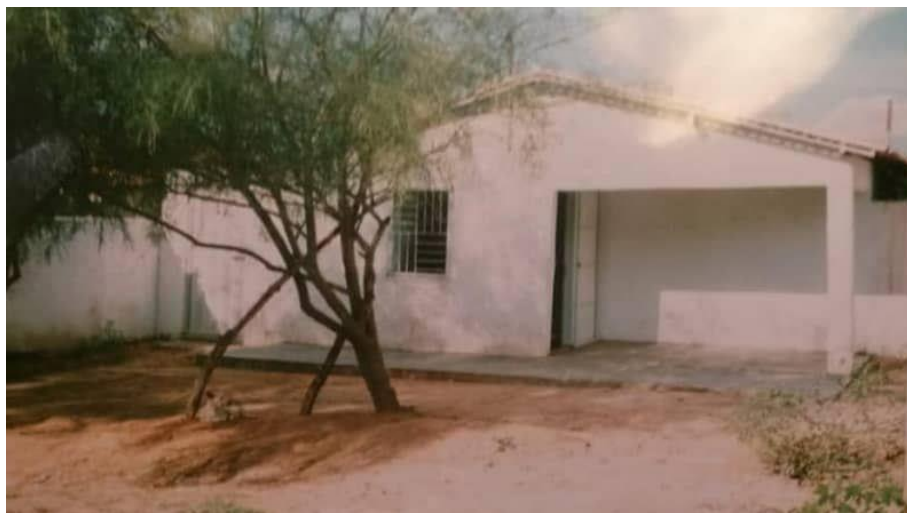
Figura 3: Fachada da Casa Aliança após alguns acabamentos, por volta de 2003.
