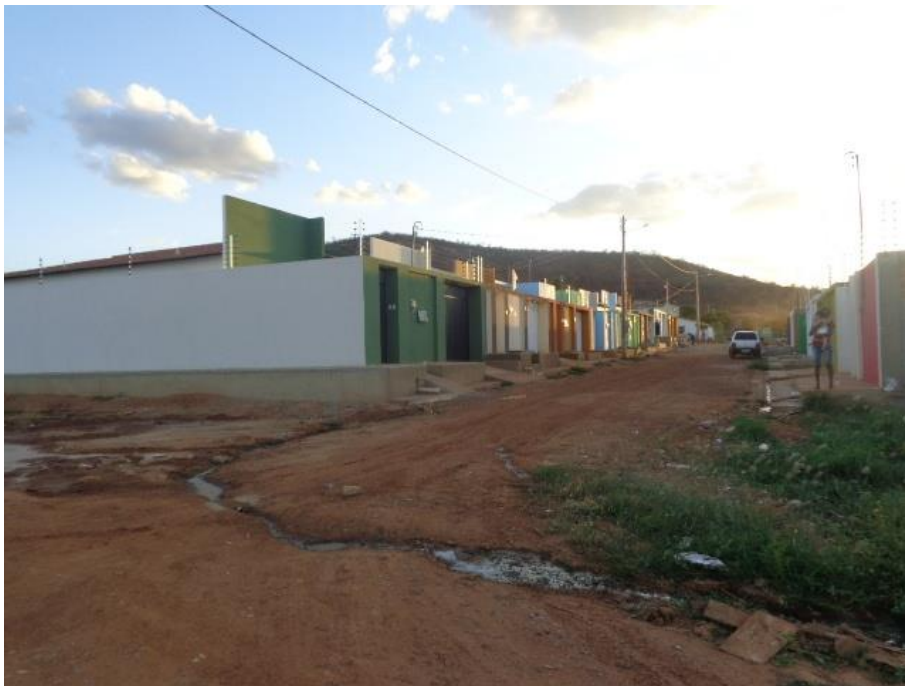
Figura 10: Rua sem pavimentação e com esgoto a céu aberto no bairro Parque de Exposição, em 3 de dezembro de 2014. Fonte: Portal Riachonet.
