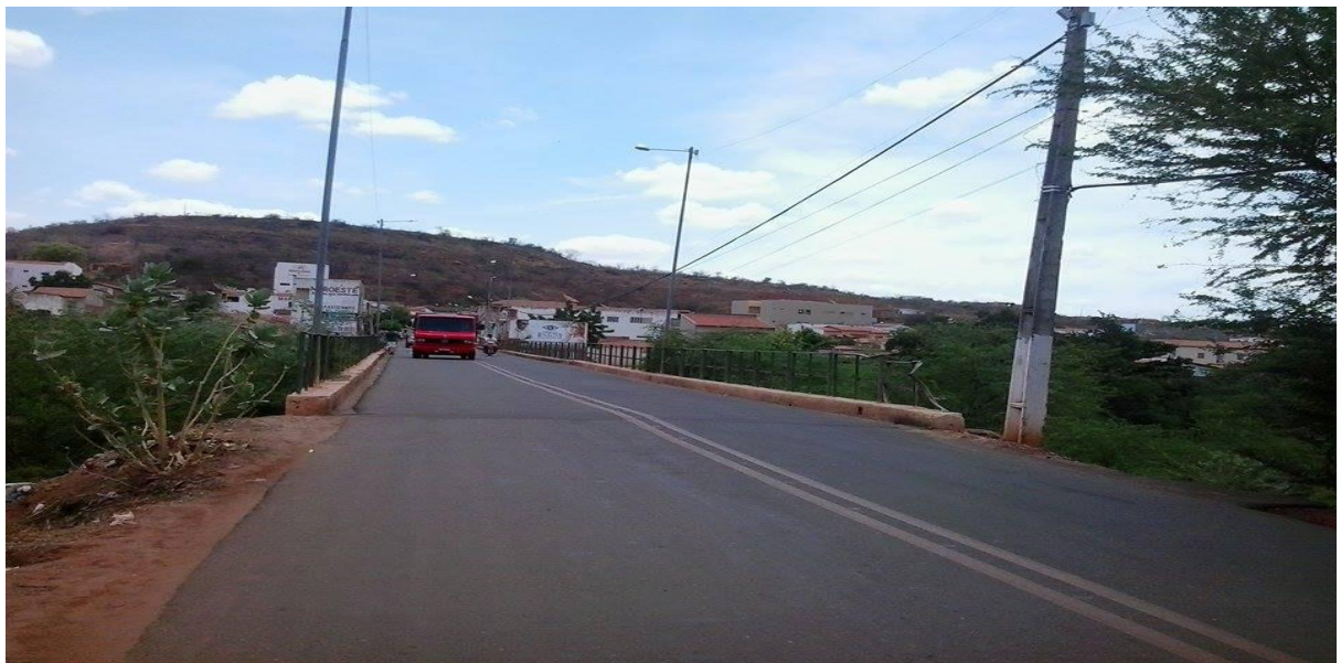
Figura 13: Ponte Eulálio Damasceno sobre o Rio Guaribas, localizada no Bairro Passagem das Pedras em 25/11/2014.
