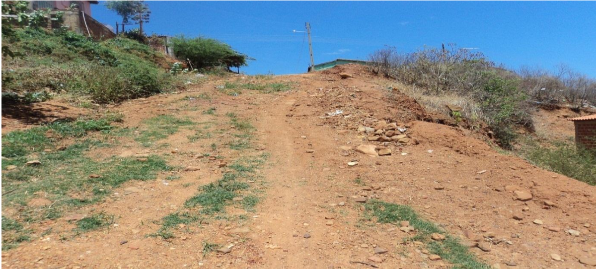
Figura 12: Ladeira sem calçamento na Avenida Quatro de Julho no morro Belo Horizonte, em 06/10/2014. Fonte: Arquivo Pessoal de Ana Beatriz de Matos.
