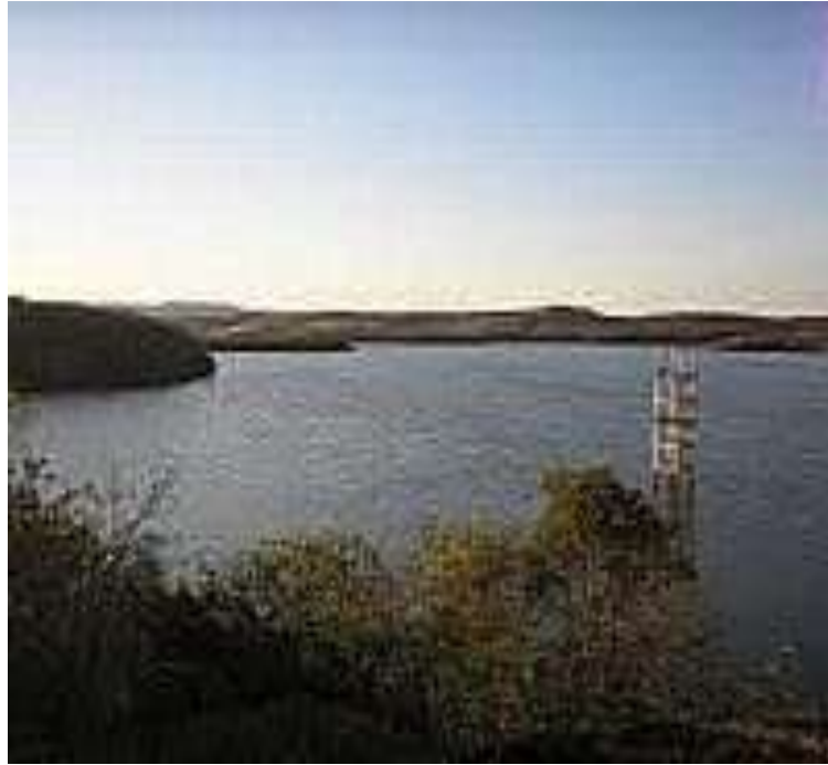
Figura 7: vista da barragem Bocaina.
