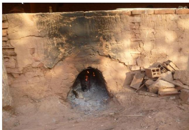
O forno tradicional é construído de barro e cimento em forma de um altar com a parte interior ocada, onde é colocada a lenha para atear fogo. A parte exterior de
