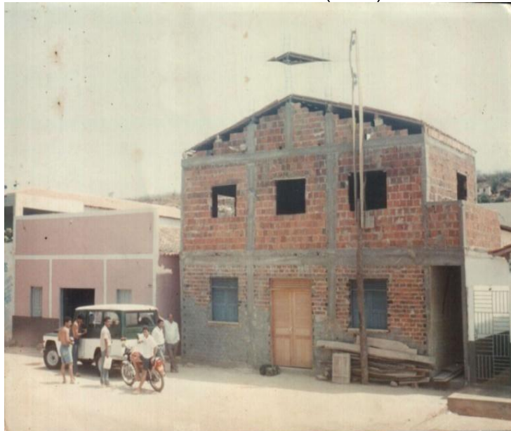
Fotografia 19. Reforma do Templo Central da Assembléia de Deus de Picos – PI (1991).
