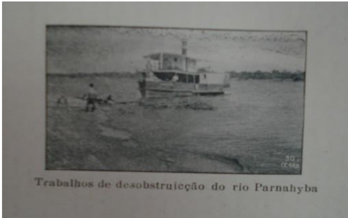
IMAGEM VIII: Trabalhos de desobstrução do Rio Parnaíba. FONTE: Relatório de Governo do Capitão Landry Salles, interventor federal do Estado do Piauí (1931-35).
