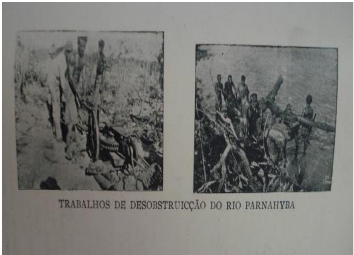
IMAGEM VII: Trabalhos de desobstrução do Rio Parnaíba. FONTE: Relatório de Governo do Capitão Landry Salles, interventor federal do Estado do Piauí (1931-35).
