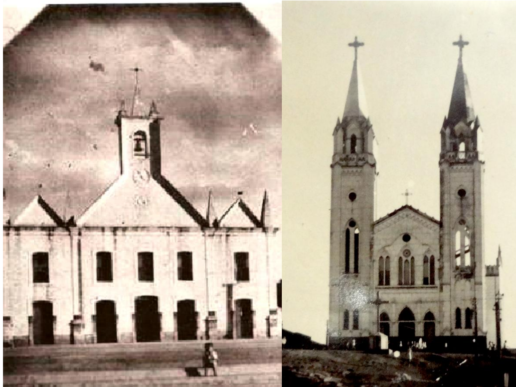
Figura 05: (à esquerda) Fachada da antiga Matriz, pouco antes da demolição; (à direita) Construção da nova igreja Matriz de Picos.
