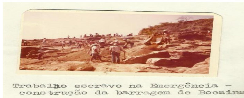
Imagem 03: frentes de trabalho na Construção da Barragem de Bocaina
