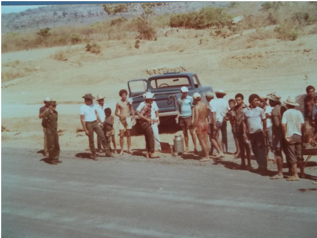
Figura 01: Homens trabalhando, início das obras da BR-230 Oeiras/Gaturiano.
