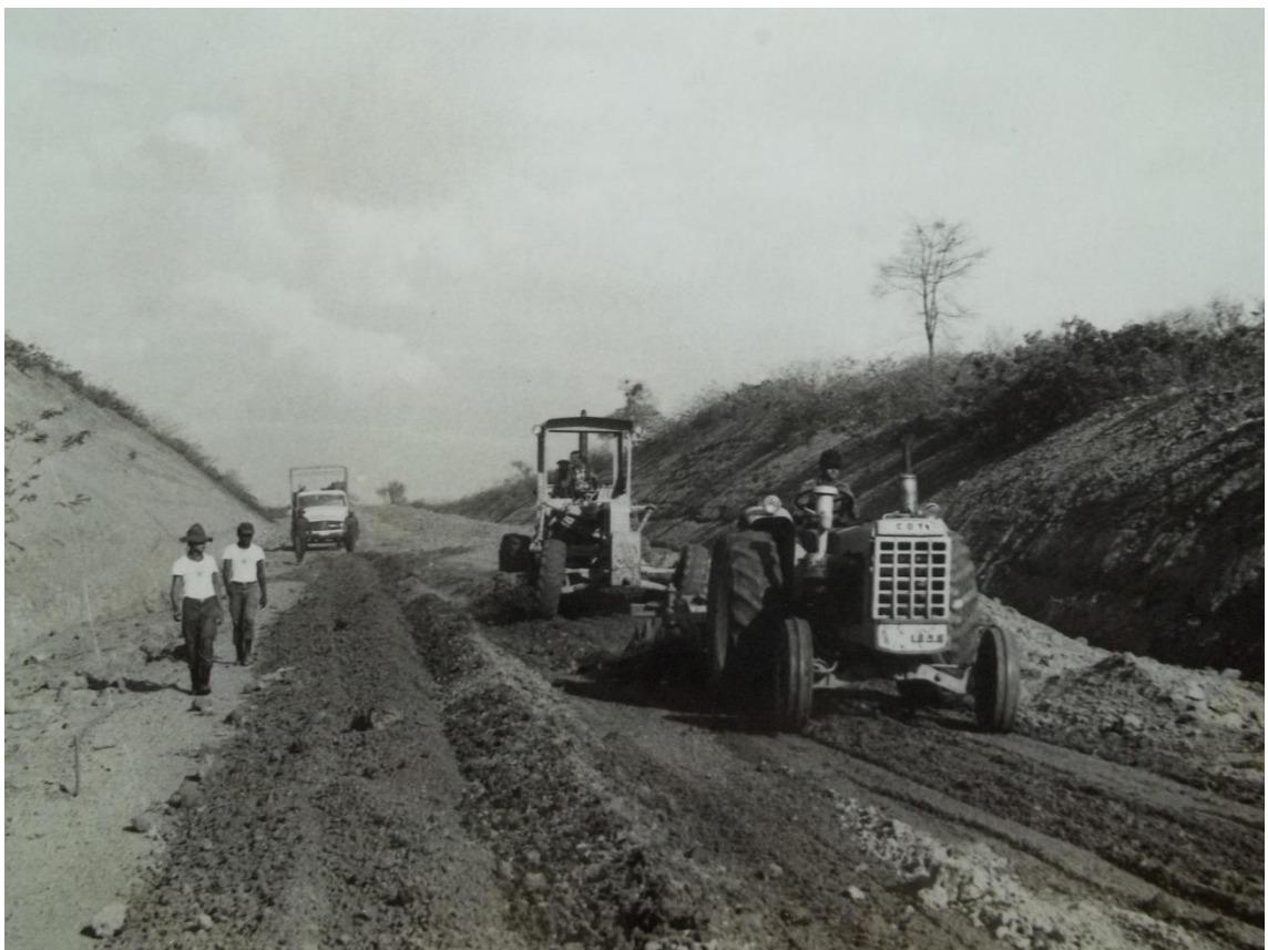
Figura02: Equipe de terraplanagem obras da BR-230
