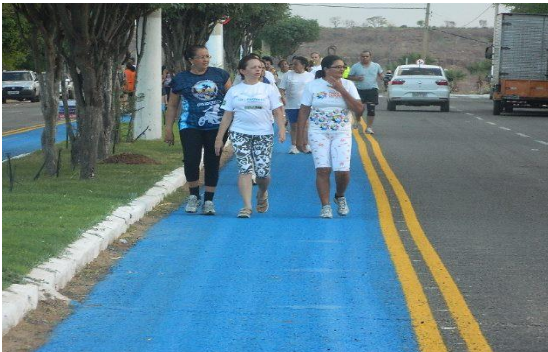
Imagem 4 – Sinalização Horizontal na Avenida Severo Eulálio
