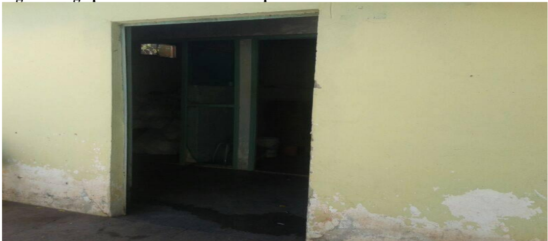
Figura 01- galpão na área externa do hospital
