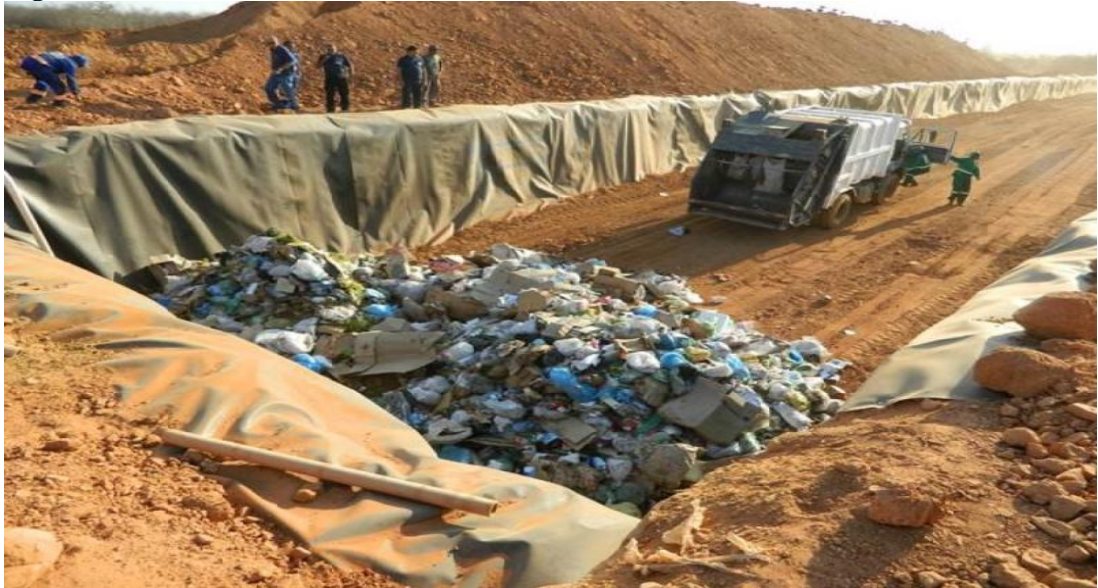
Figura 4-Atual aterro sanitário na cidade de Picos no bairro Val Paraíso
