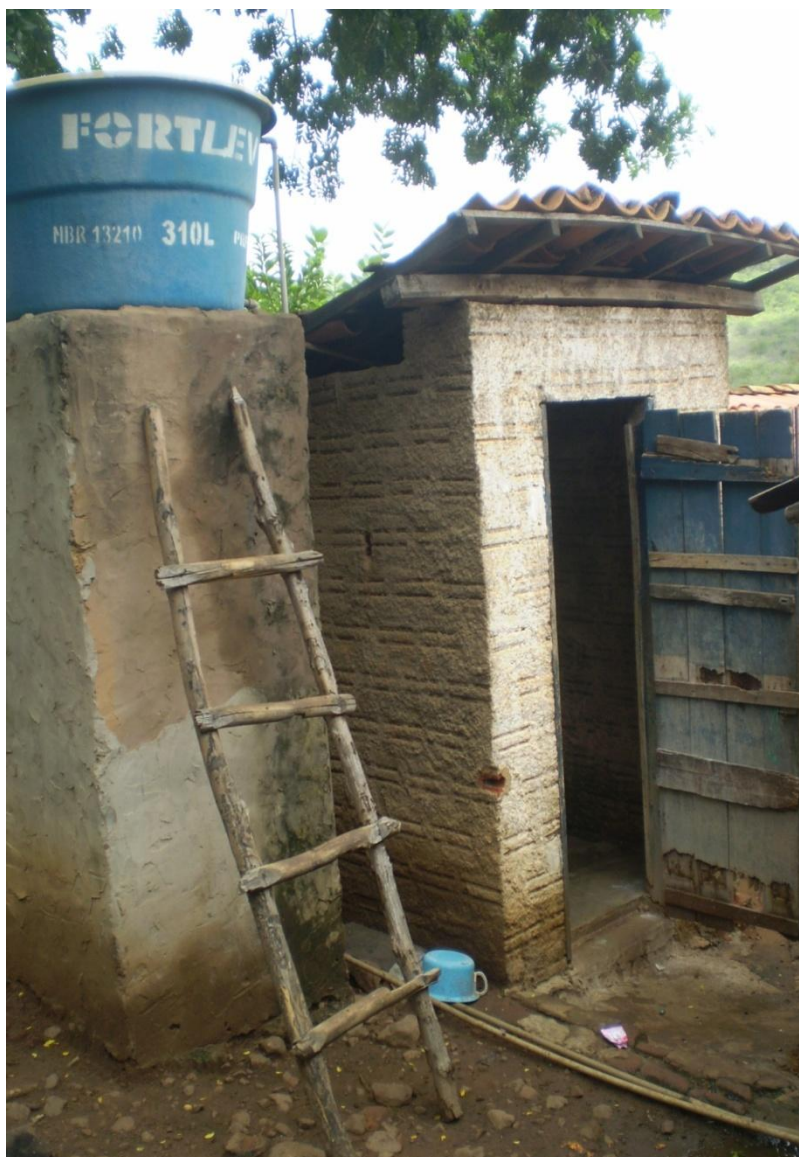
Fotografia 06: Banheiro construído pelo programa da prefeitura
