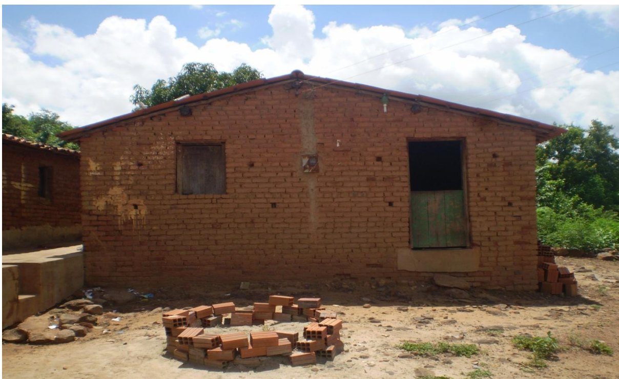
Fotografia 03: casa de Alvenaria construída com adobro.
