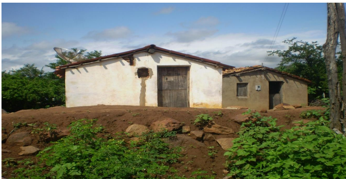
Fotografia 10: Casa sem organização estrutural para pavimentação de ruas
