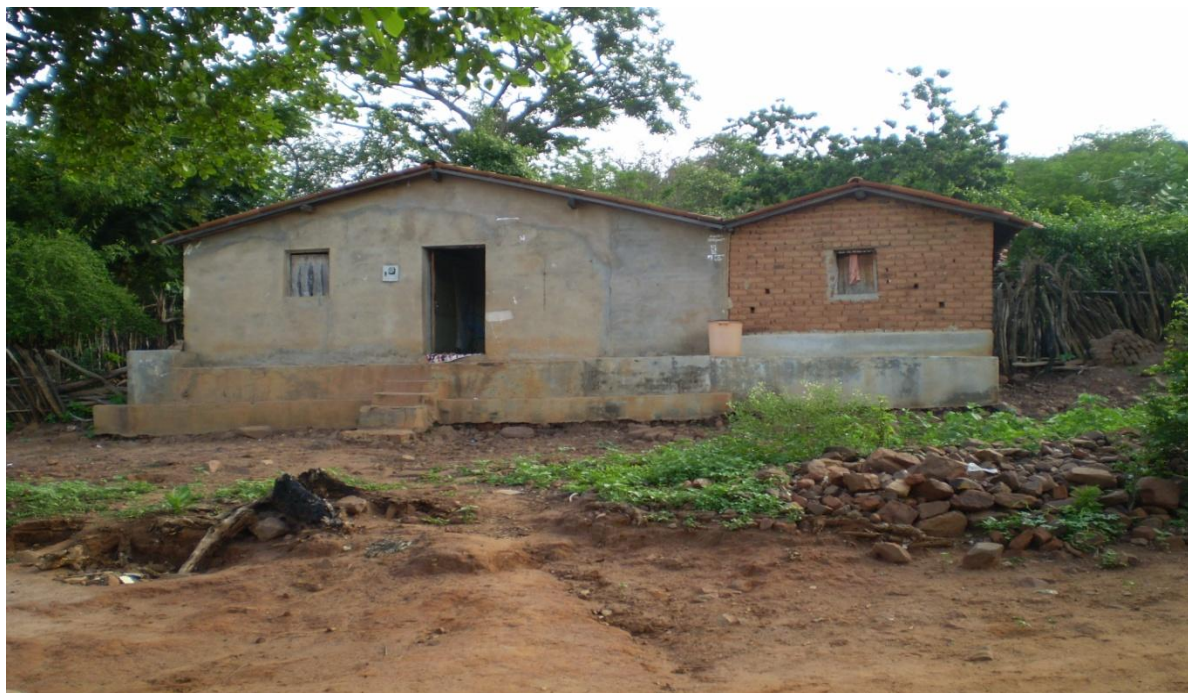
Fotografia 02: casa de Alvenaria construída com adobro
