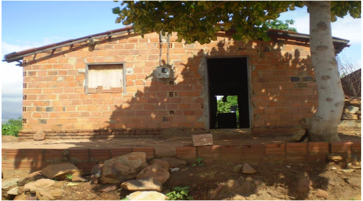
Fotografia 04: casa de Alvenaria construída com bloco
