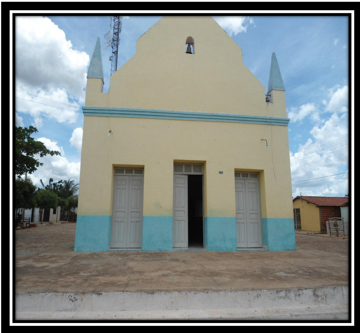
FOTO 12: Igreja São José (2011) construída em mutirão social em 1940 FONTE: Paulo Rodrigues Filho.
