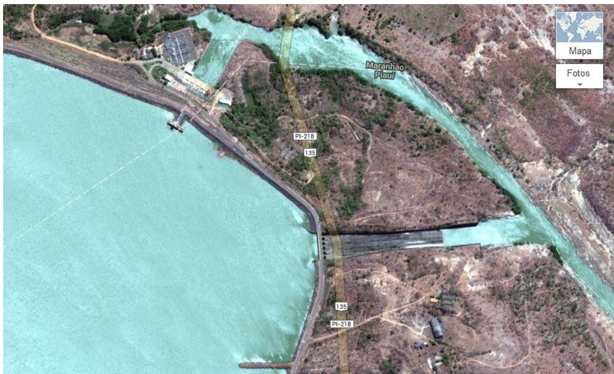
Foto 03: A Usina Hidrelétrica de Boa Esperança, vista do Satélite. Fonte: https://maps.google.com.br ; Acesso em 01/09/2013.
